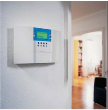
Abbildung 1 Steuergerät und Funk-Thermostatventil einer Zentralen Einzelraum-Temperaturregelung der Firma Techem
